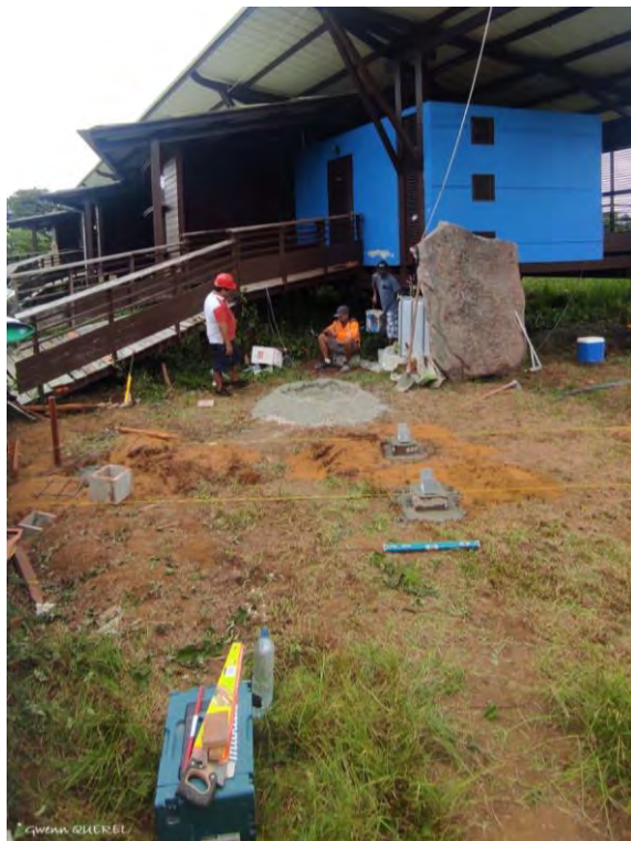
▲ Travaux sur la Maison de la Réserve ©RNNKR
